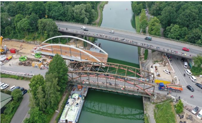
Blick auf die Baustelle in Münster
